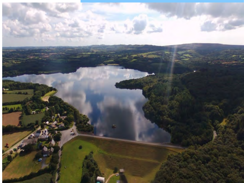
Barrage du Drennec (source : Syndicat de bassin de l'Élorn).
